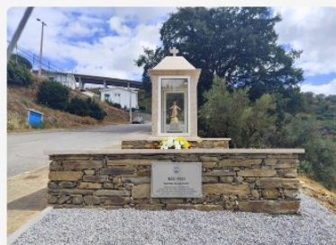
Construção do Nicho de São Paio
