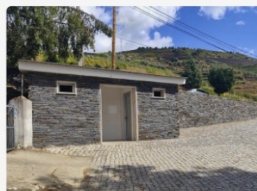
Construção das Casas de Banho Públicas no Cemitério da Freguesia
