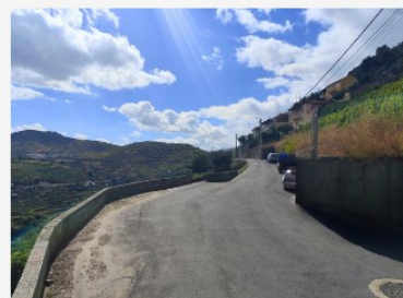
Alargamento da Rua do Serrinho
