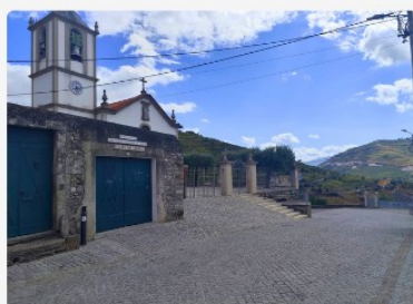
Requalificação da escadaria e zona envolvente da Igreja Paroquial
