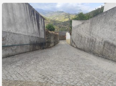
Pavimento e sinalização da Rua de Santo António
