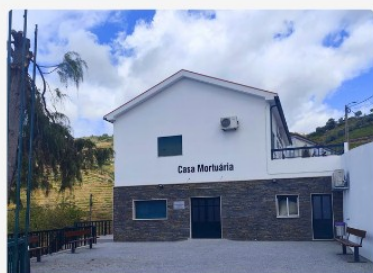
Construção da Casa Mortuária
